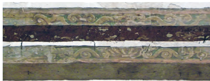
V odstranjeni leseni konstrukciji nosilnih tramov podesta pevskega kora sta bila najdena dva tramova, ki sta poslikana.
