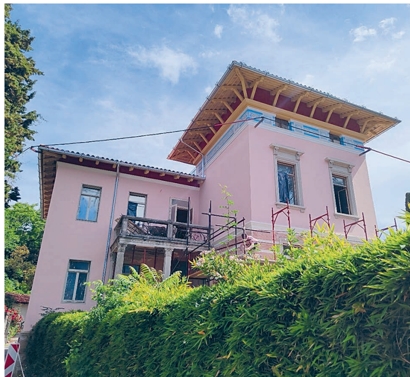
Secesijska Vila Napoli v Portorožu po obnovi fasade, lesenega napuščja in štukaturnega okrasja
