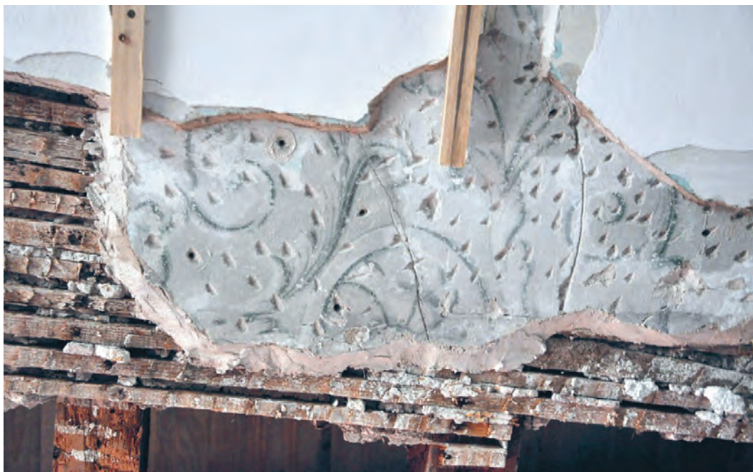
Starejša plast poslikave po izvedeni intervenciji stabilizacije ometa v prostorih prvega nadstropja.
