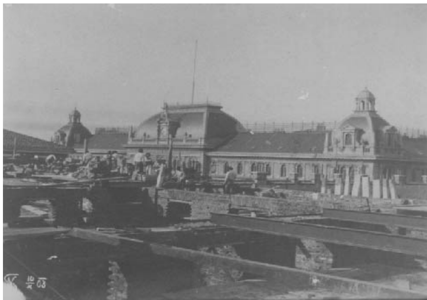
Ill. 3 Narodni dom: Il cantiere (NŠK OZE)
